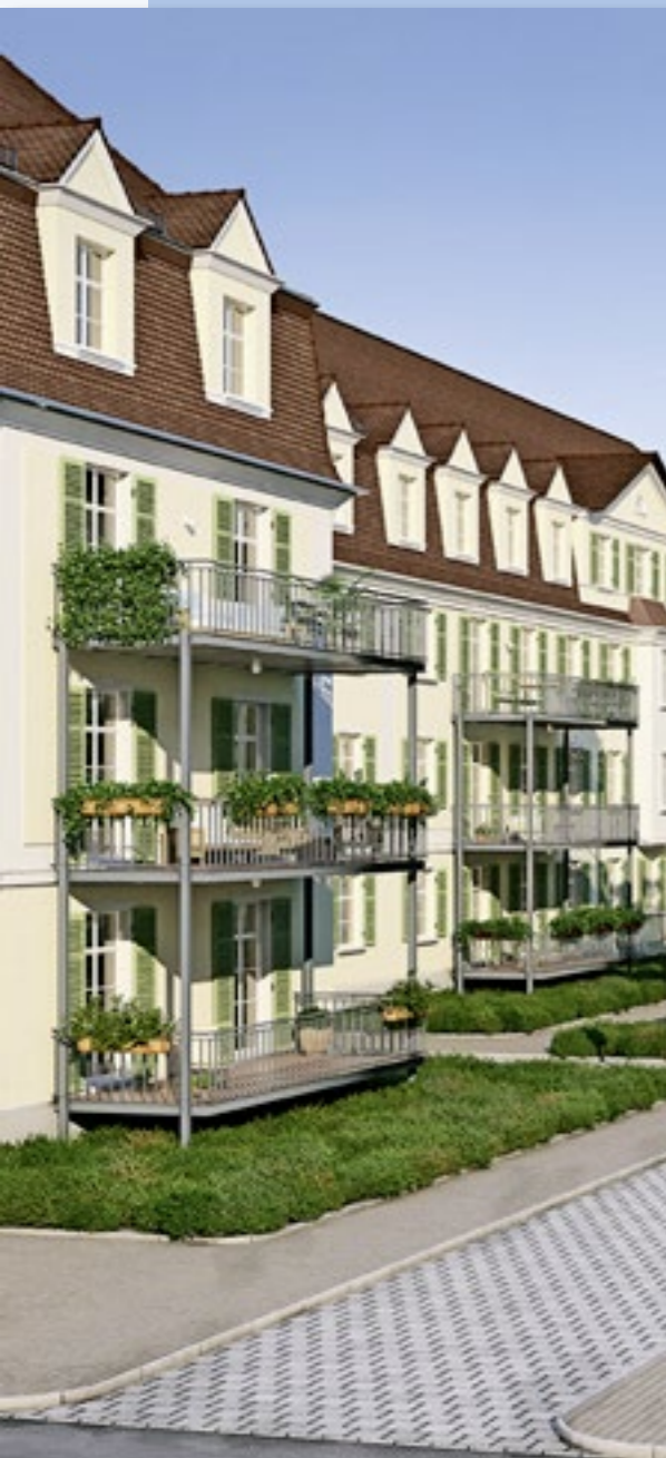
Innenhof nach der Sanierung
