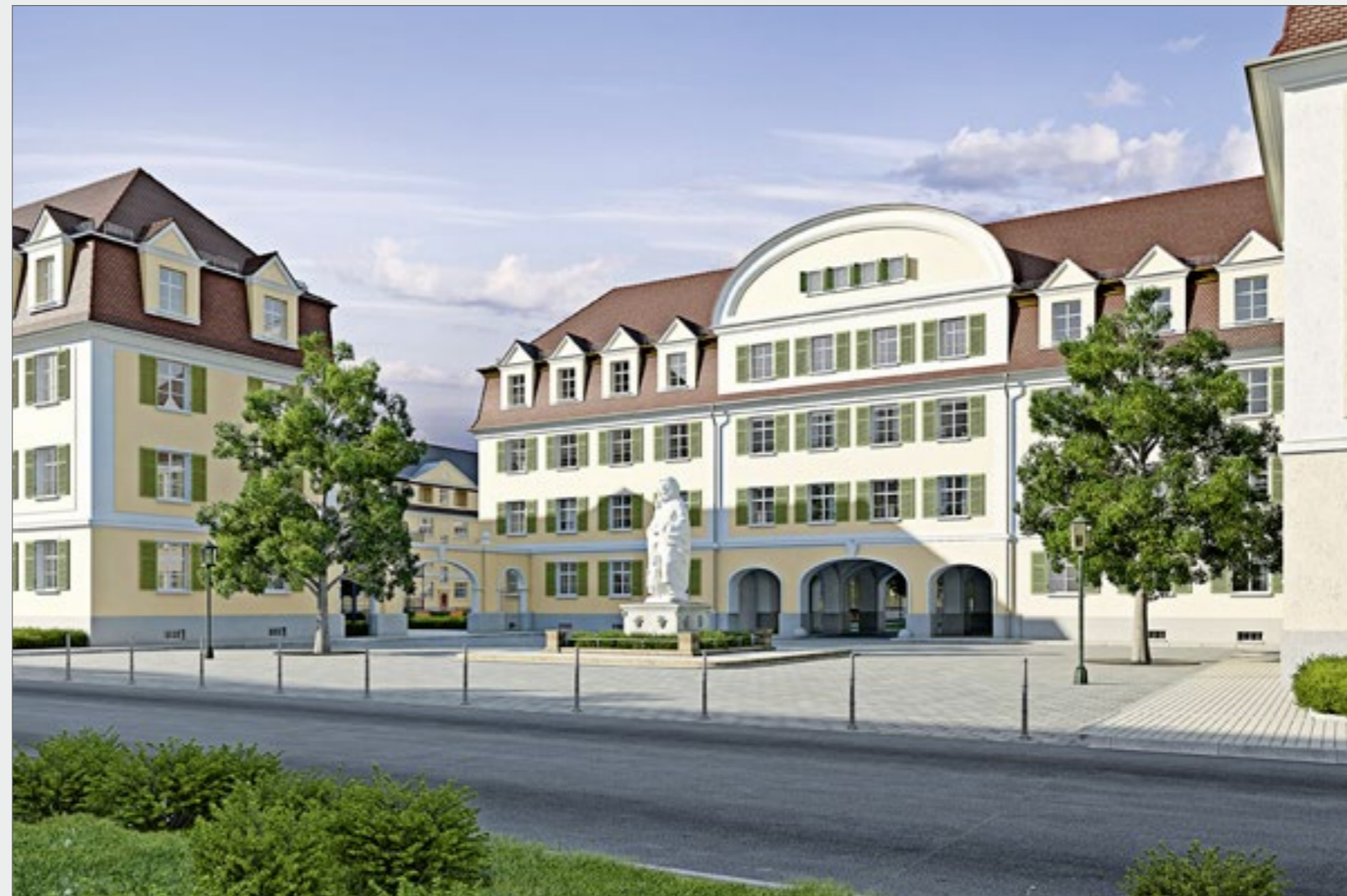
Straßenansicht nach der Sanierung
