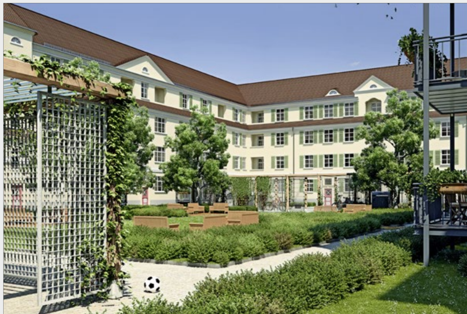
Innenhof nach der Sanierung
