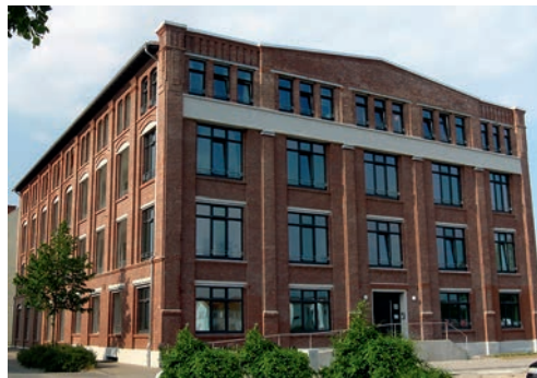
Wohnanlage Pauluscarrée in Bielefeld
